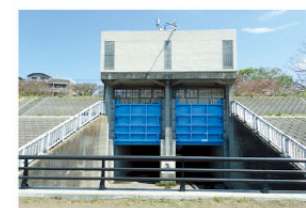
六郷排水樋管
