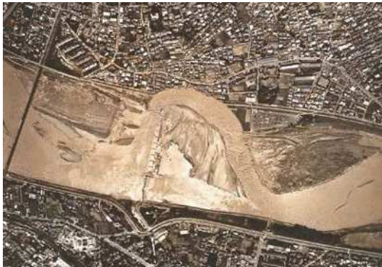
台風 16 号(昭和 49(1974)年)による被害
