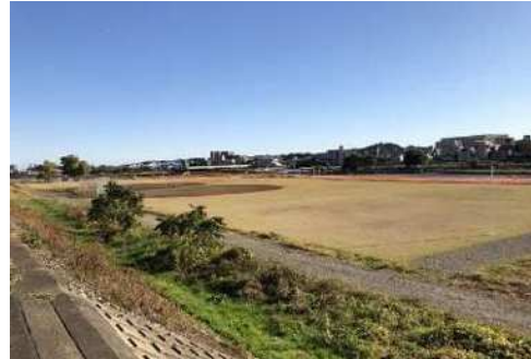
多摩川緑地公園グラウンド(復旧後)
