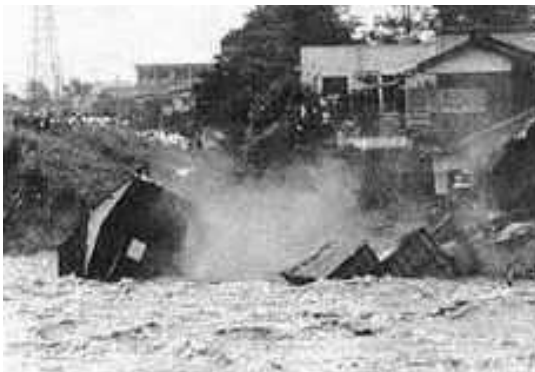
台風 16 号(昭和 49(1974)年)による被害
