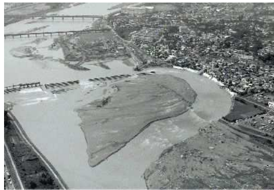
台風 16 号(昭和 49(1974)年)による被害
