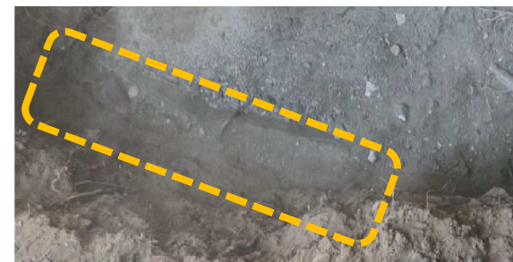
石垣に沿った護岸状構造物
