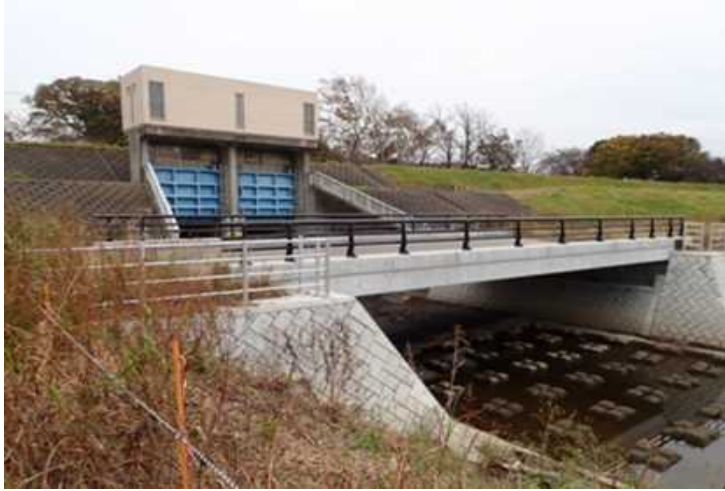
六郷排水樋管
